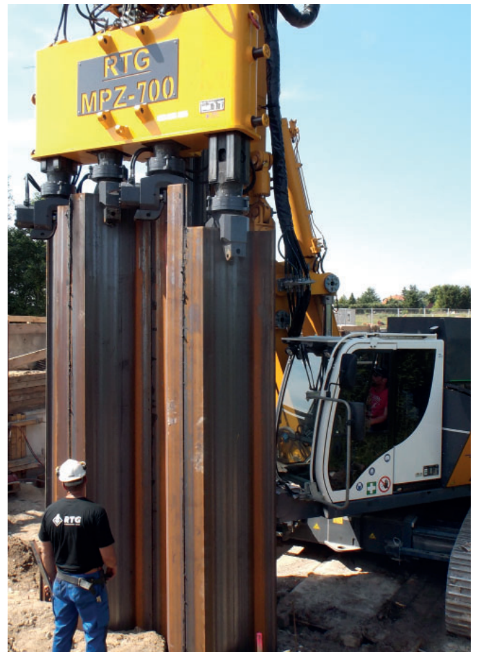
RG 16 T mit Presse MPZ-700 RG 16 T with press MPZ-700
