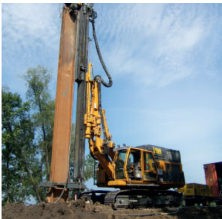
Schmalwandherstellung mit RG 19T Construction of VIB-wall with RG 19T
