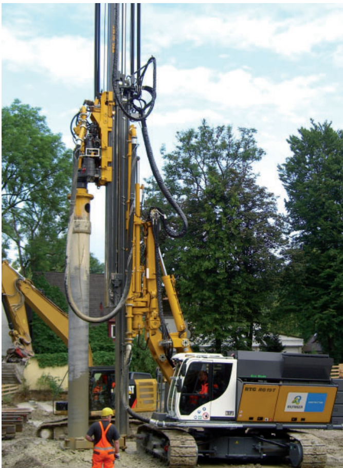
RG 19 T mit DKS 50/100T im VdW-Verfahren RG 19 T with DKS 50/100T with FoW method
