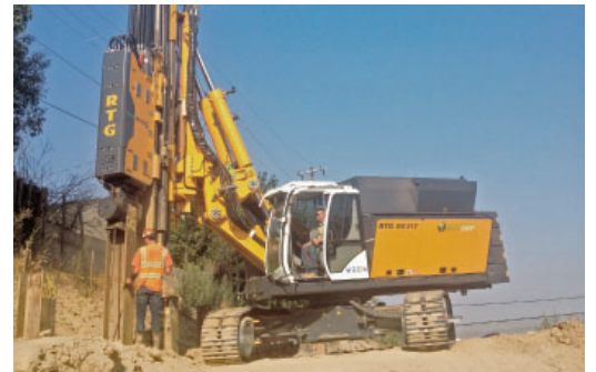
RG 21 T mit MR 150AVM beim Trägerrammen RG 21 T with MR 150AVM during driving H-beams
