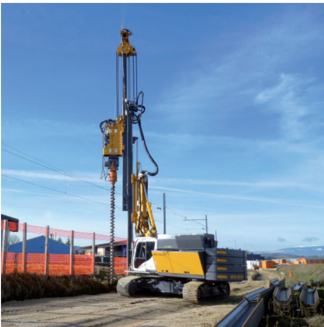
Vorbohren mit RG 19 T Predrilling with RG 19 T
