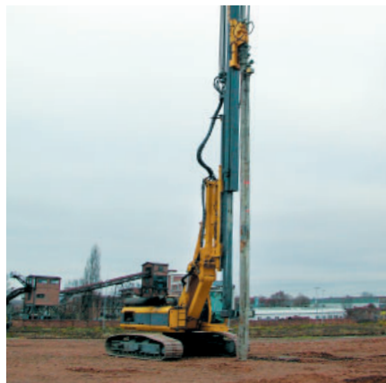
RG 18 T mit Tiefenrüttler TR 17 (Rüttelortbetonsäulen) RG 18 T with depth vibrator TR 17 (vibrated concrete columns)
