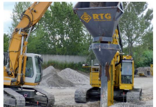
RG 16 T mit MR 150AVM im VIPAC Verfahren RG 16 T with MR 150AVM in VIPAC mode
