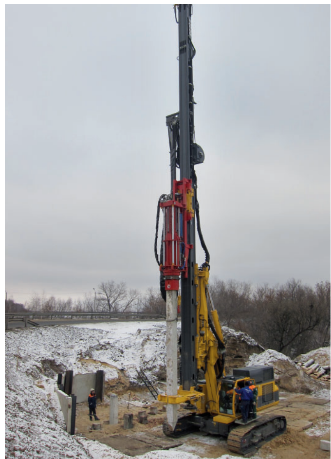
RG 22 S mit FAMBO Hydraulikhammer RG 22 S with FAMBO hydraulic hammer
